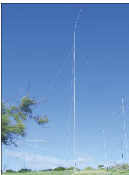
Die 27 m hohe TITANEX V160 für 1,8 MHz direkt am Strand
